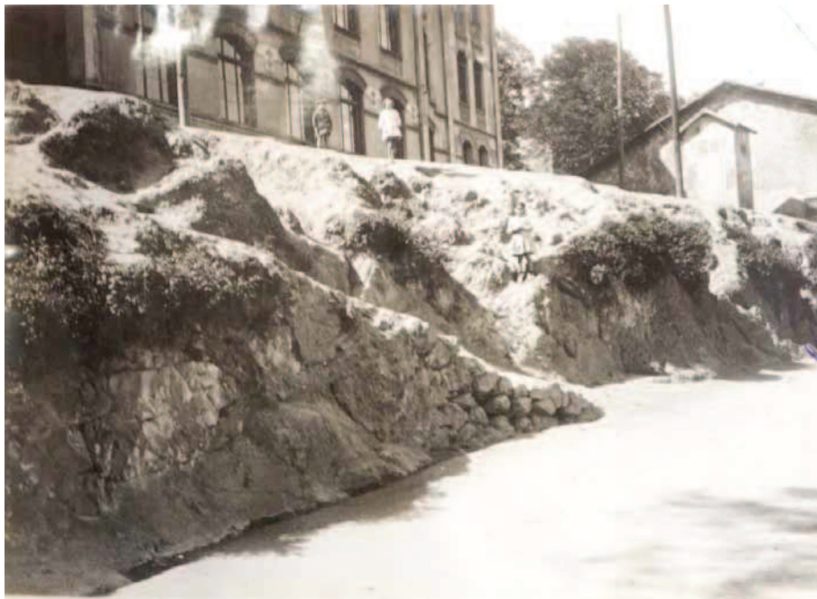
Fotografía 3. La escuela de Olabeaga y el importante desnivel sin vallar que se encontraba frente a ella. A. F. B. AMB-BUA Bilbao decimotercera 0011/001.
