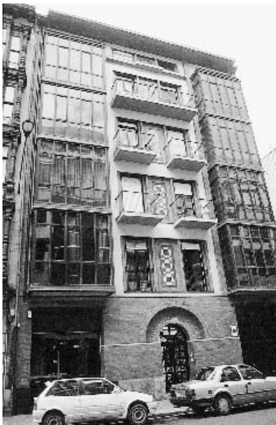
Casa de vecinos, sita en la calle Bertendona.
