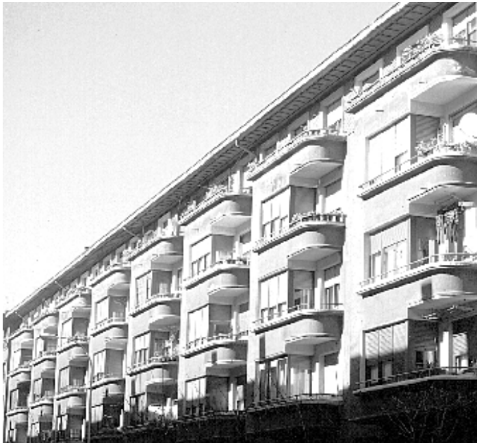
13. Fachada TM Torre Madariaga
