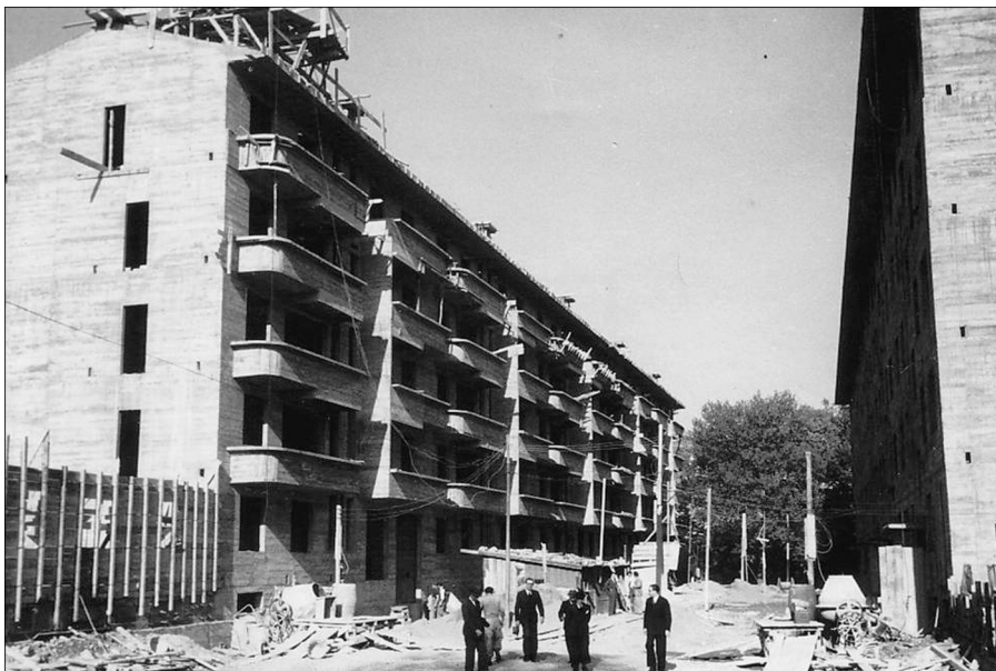
Grupo de Viviendas Municipales de Torre Madariaga en construcción. Archivo de Viviendas Municipales de Bilbao . Caja VIII
