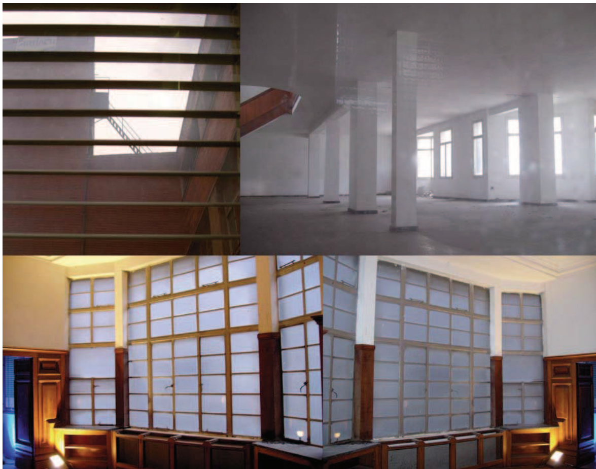
Fig. 4. Reforma y rehabilitación de la conocida fábrica Artiach en Zorrozaurre.
