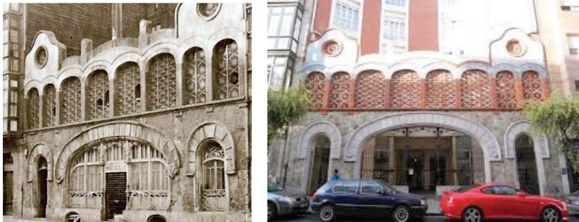
Fachada del lavadero de la alameda de San Mamés en ruinas y después de restaurada
