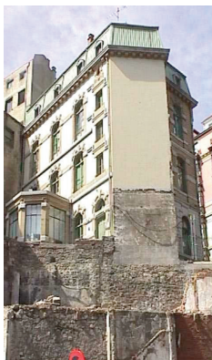
Casa de Socorro de San Vicente desde Uribitarte en 1996 (Fotografía del autor).
