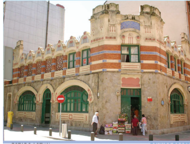
Lavadero de Castaños dedicado a mercado (fotografía de AMB-BUA) Centro de Desinfecciones de la calle Zancoeta 15
