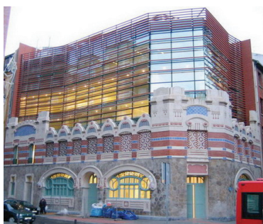
Fachada del lavadero de Castaños (fotografía de AMB-BUA)
