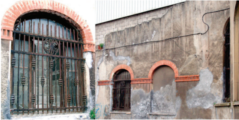
FIGURA 7. Portada y fachadas laterales de Coromina Industrial, vestigios de una arquitectura singular ‘ornamentada’ de ladrillo visto.
