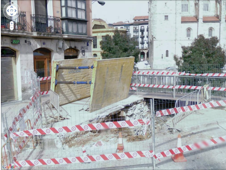
Apertura de la zanja, donde se ven las dovelas de una parte del tercer arco del viejo puente (Google Street View, septiembre 2008).
