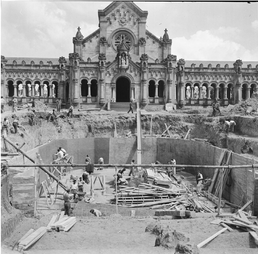
Fotografía 2: Imagen de la construcción de la Cripta Mausoleo (1938).
