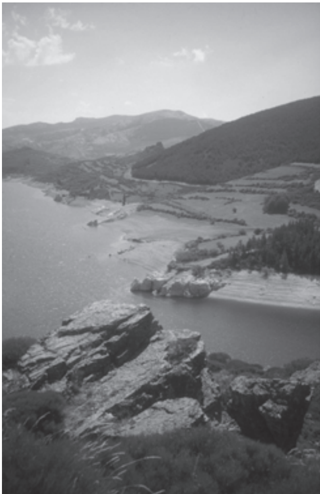
FOTO 2 Vista del embalse de Camporredondo (Palencia). Naturaleza determinada por la obra civil.
