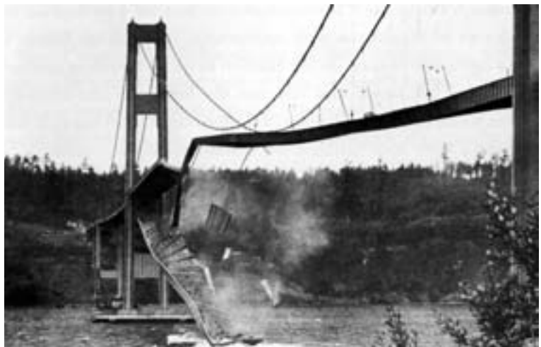
FIGURA 7 La rotura del Puente de Tacoma.
