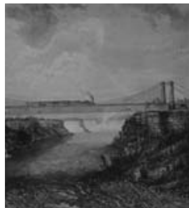
FIGURA 8 Puente colgante del Niágara, de Roebling.
