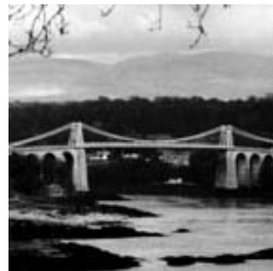
FIGURA 4 Puente de Menai, de Telford.
