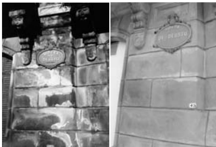
] a) Formación de costras sobre la arenisca b) Limpieza y cambios en la pátina, la grafía y la ortografía.
