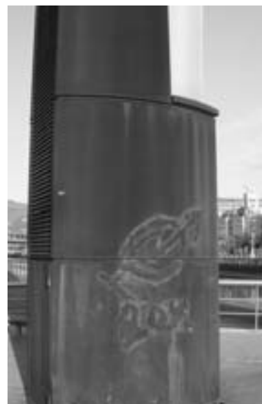
Linterna en acero cortén. Difícil eliminación de las huellas del vandalismo.
