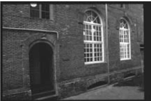
FOTO 3 Ventanas de la antigua sala de cocidas. Carlos Colás.
