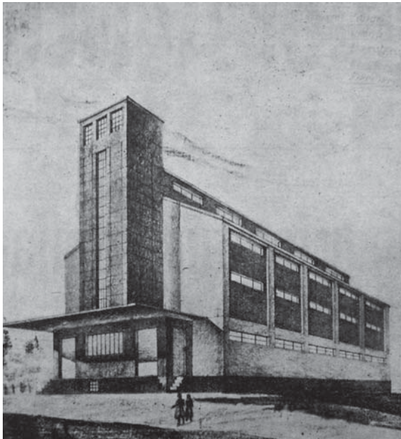
FIG. 6 Silos en Albania.
