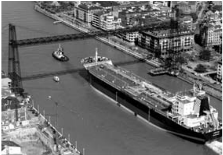
FIGURA 12 Puente Colgante (Ría de Bilbao. España)
