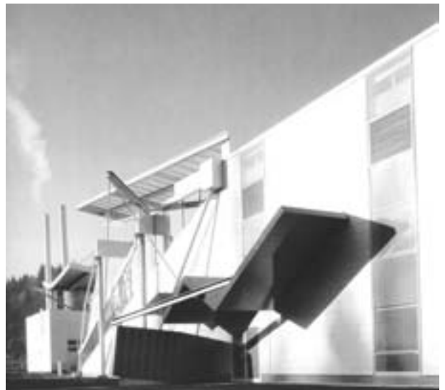
FIGURA 8 COOP HIMMELBLAU: Complejo fabril Funder Werk 3 en St. Veit/Glan, 1988-1989. Vista general. La central energética con las «chimeneas danzantes» está separada de la nave de producción, comunicándose con ella por un puente.
