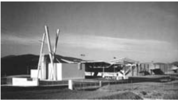
FIGURA 8 COOP HIMMELBLAU: Complejo fabril Funder Werk 3 en St. Veit/Glan, 1988-1989. Vista general. La central energética con las «chimeneas danzantes» está separada de la nave de producción, comunicándose con ella por un puente.
