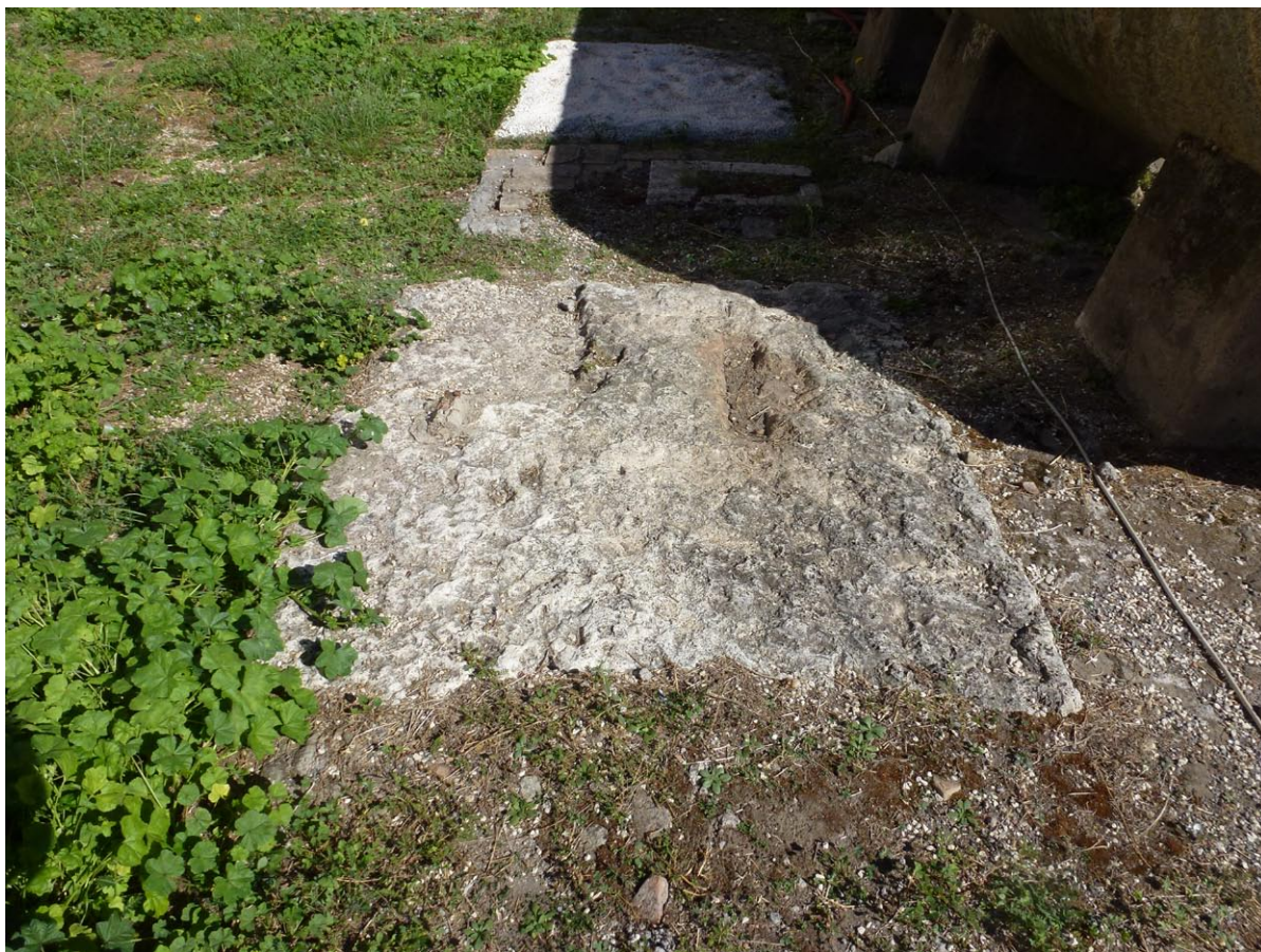
FIG. 20. Cortile della colonna Traiana. Le fondazioni in travertino delle colonne del porticato settentrionale. Sulla superficie dei blocchi si vedono le tracce della scalpellatura (foto dell'A.).
