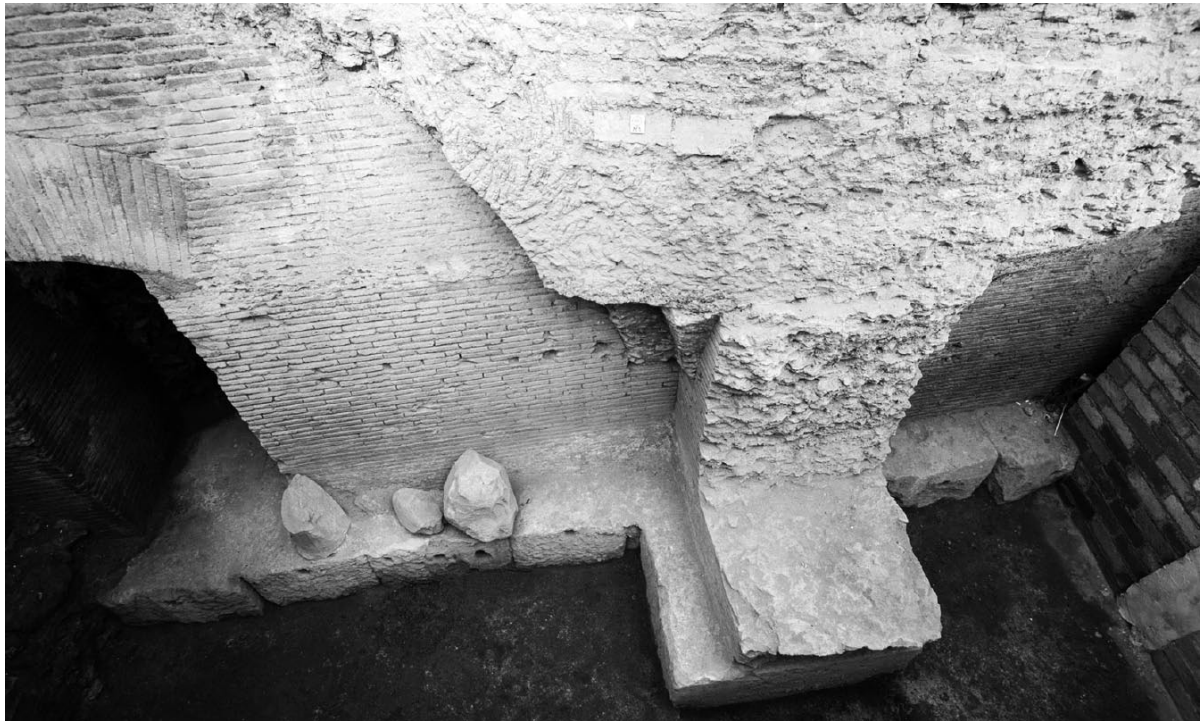
FIG. 9. Ex sala mensa, ambiente 1: gli ambienti in opera laterizia con attacchi delle volte a crociera (da Baldassarri 2013).
