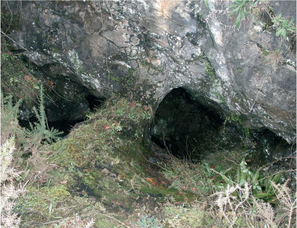
FIGURA 5. Fortificación primitiva, en pendiente, con el sistema de pilar y arco rebajado, relicto situado en el tramo oeste de los «Pozos de arriba» (Foto de A. Villa Valdés).
