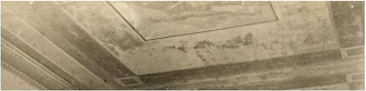
FIGURA 8. Detalle del techo de la terraza. Fundación Vicente Blasco Ibáñez
