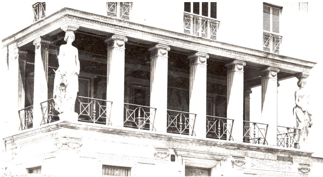
FIGURA 2. Detalle de la Fachada del Chalet de la Malvarrosa. Fundación Vicente Blasco Ibáñez. Depositada en la Casa-Museo Blasco Ibáñez (Valencia)
