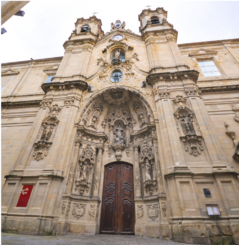
Fig. 1: Exterior de la iglesia de Santa María de San Sebastián
