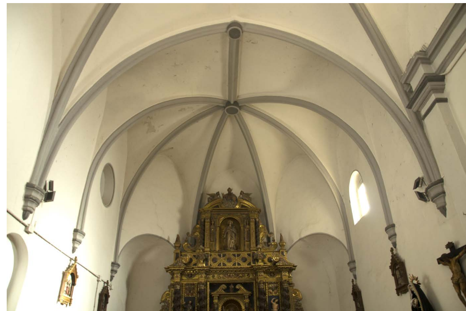
Fig. 3: Bóveda poligonal mediante trompas de la cabecera de la iglesia de Santa María de Bulbunte. (Fotografía del autor)
