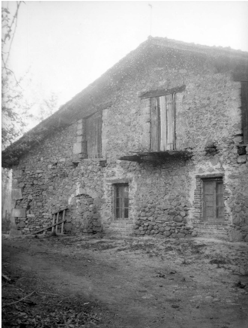
Fig. 2: Vista parcial de una de las fachadas de astal de la Ferrería de Lebario, Abadiño, Bizkaia. 1925. Desconocido. F/003475. © Euskal Museoa. Bilbao
