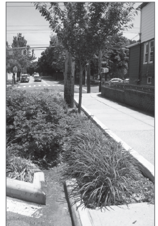
Canal de filtración biológica integrado en el paisaje urbano. Fuente: Green Cities . SCI Fall 2009, p. 48.
