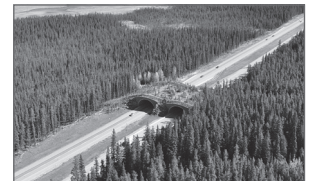
Fig. 2: Trans-Canada Highway Overpass. Fuente: www.esa.org
