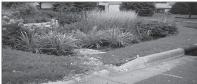
Fig. 6: Filtración de agua en el lugar. Fuente: Green Cities . SCI Fall 2009, p. 43.
