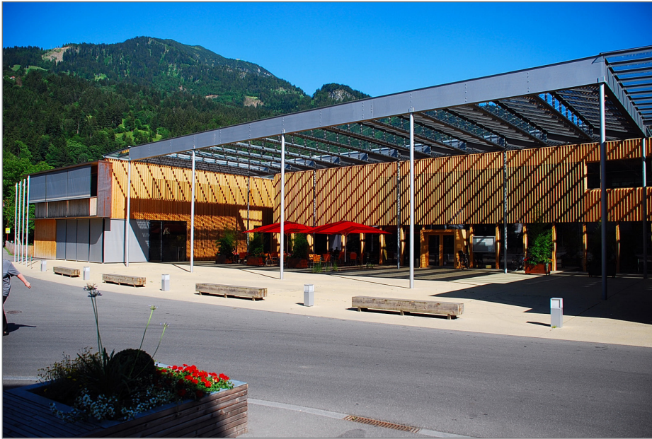
Figura 7. Imagen de la plaza cubierta con paneles fotovoltaicos del Centro Comunal de Ludesch, Vorarlberg, Austria. Arquitecto Hermann Kaufmann. Imagen del autor
