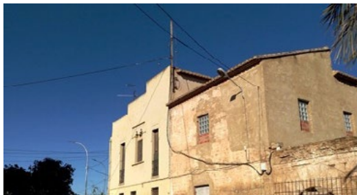
Fig. 13. Imagen del estado actual del elemento 13. l'Alqueria Fonda, 2019
