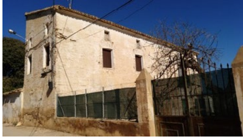
Fig. 2. Imagen del estado actual del elemento 2. l'Alqueria LLeonard, 2019
