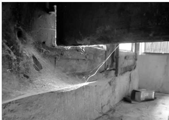
Aula de la escuela antes de su restauración
