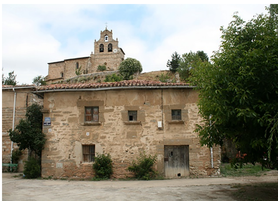
Fachada de la escuela de Bañuelos antes de su restauración
