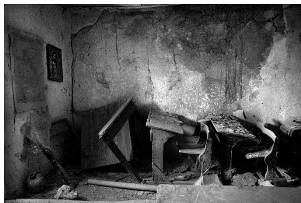
Aula de la escuela antes de su restauración
