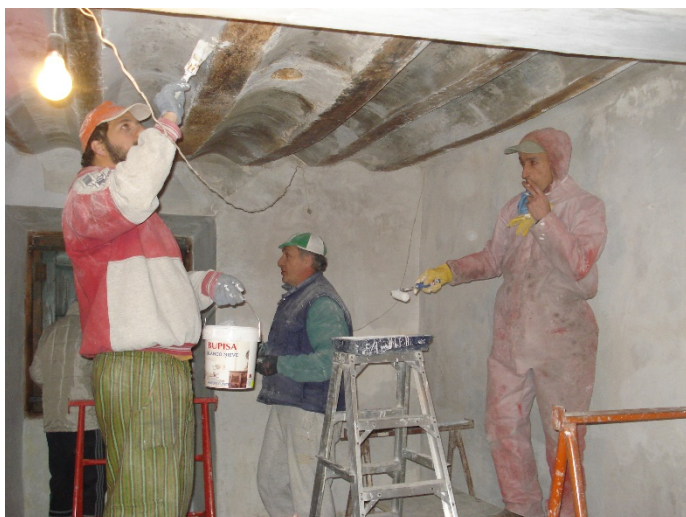
Pintando en una de las fases de la obra, 07.12.2014.
