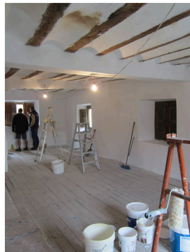
Pintando en una de las fases de la obra, 03.03.2015.
