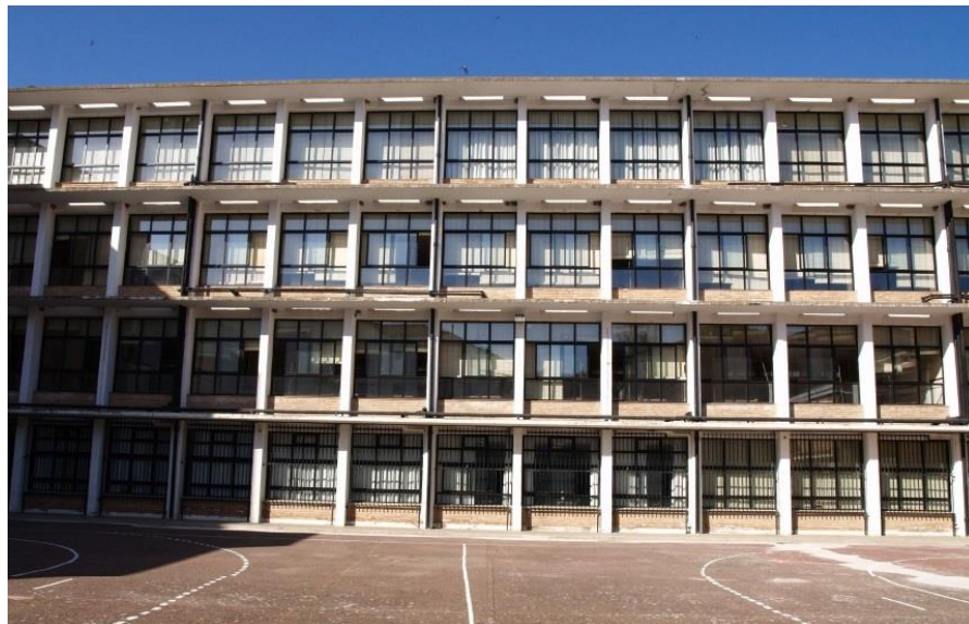
Ilustración 1. Fachada principal del IES "Pedro Espinosa"
