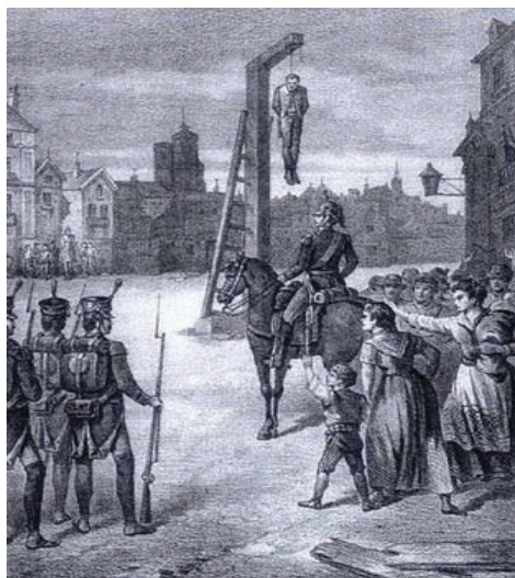
Imagen 2. Ejecución de Riego en la Plaza de la Cebada de Madrid.
