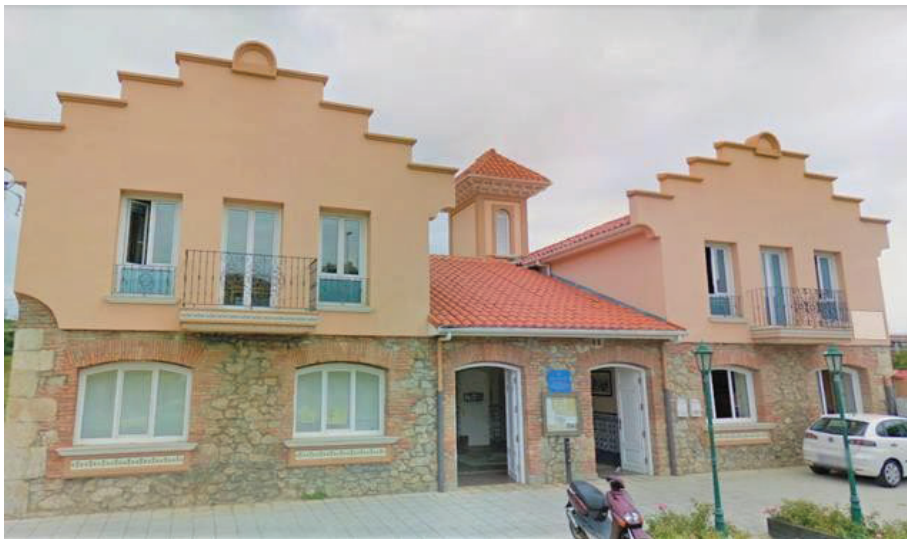
Graduada José Antonio de Peñacastillo (Santander), actualmente sede de un centro cívico del Ayuntamiento de Santander
