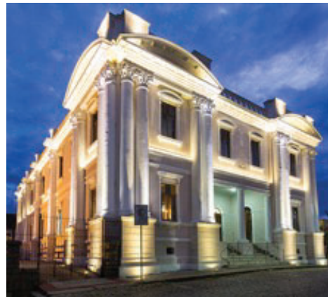
Figura 2. Fachada iluminada. Fuente: colección del Museo de la Escuela Catarinense
