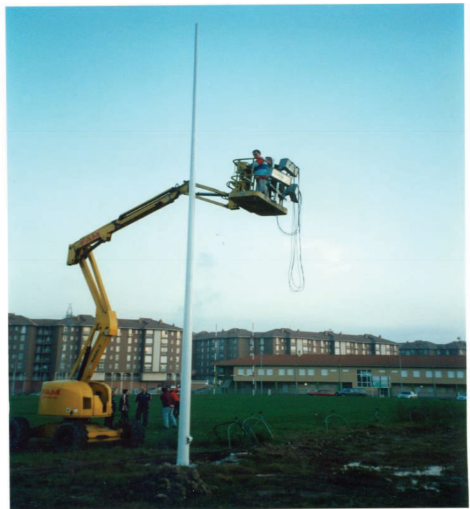
12003: Instalación de los remozados focos regalados por Obras Públicas
