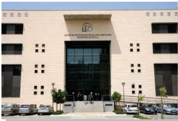
Fig. 1. Vista exterior del edificio CITIUS (Campus de Reina Mercedes, Sevilla).
