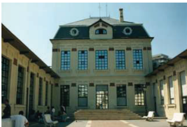
Fachada posterior del edificio de las Escuelas del Dr. Velasco, actual Casa de Cultura
