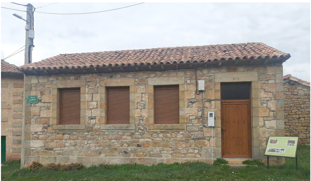
Imagen 2. Escuela de Castrillo de Valdelomar, tras su restauración en 2019
