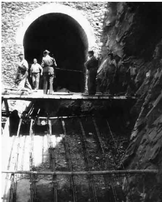
Obras de construcción del ferrocarril de Sukarrieta a Bermeo. Una pareja de la Guardia Civil vigila a los presos utilizados como mano de obra esclava por la empresa Banús Hermanos. Archivo Euskotren/Museo Vasco del Ferrocarril.
