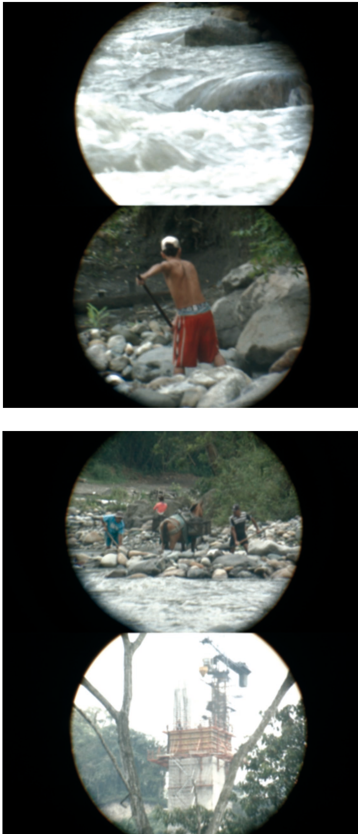
Extracción de material de río, y construcción de viaducto cerca al río Coello. Tolima, 2019
